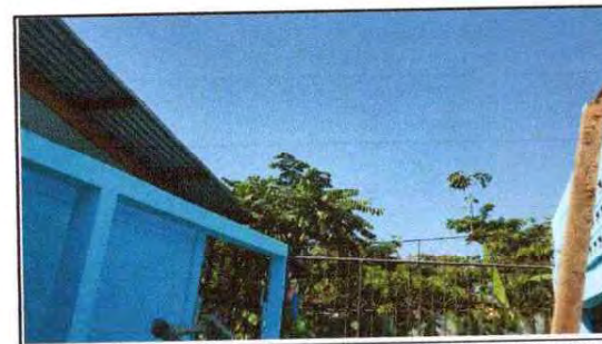
FOTO 11: Sustitución de lámina, por lámina troquelada aluzinc calibre 26 Y Sustitución de estructura de soporte de madera, por metal EN AULAS
