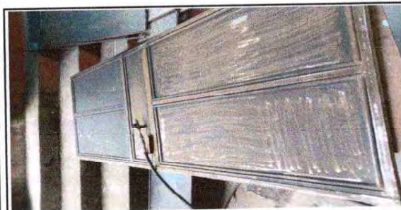
FOTO 5: Mantenimiento a estructura (lijado, cambio de tubo, cepillado, sujeciones, aplicación de pintura) (2 x1 mts)
