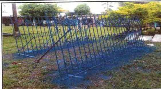
FOTO 14: Mantenimiento a balcones de metal EN AULAS
