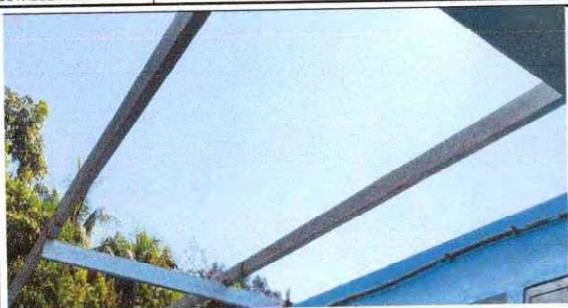
FOTO 1: Sustrucción de lámina, por lámina troquelada aluzinc calibre 26 EN BAÑOS
