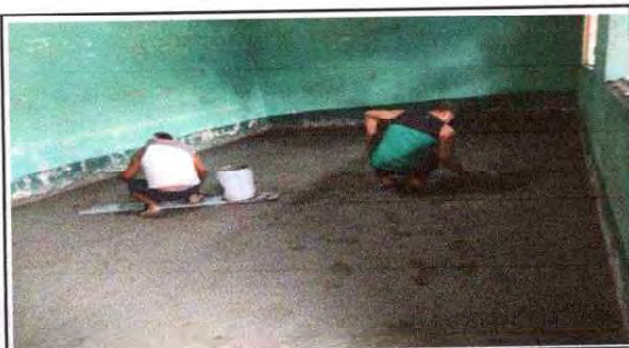
FOTO 15: Reparación de piso de cemento liquido
