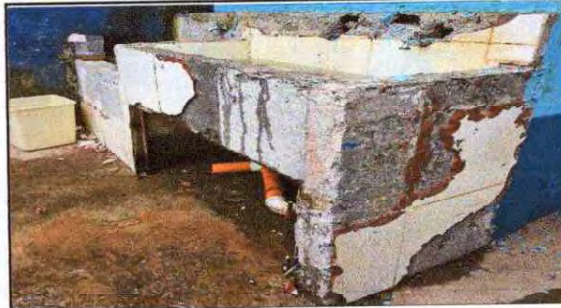
FOTO 4: Sustrucción de Azulejo para pila en Baños
