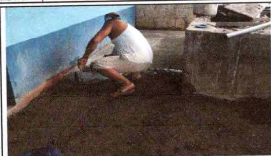
FOTO 7: Sustitución de piso de torta de concreto EN COCINA
