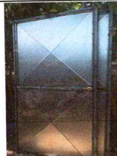
FOTO 2: Mantenimiento a estructura (lijado, cambio de tubo, cepillado, sujeciones, aplicación de pintura) a puertas servicios sanitarios
