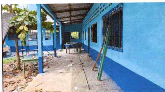
FOTO 16: Pintura en muros exteriores e interiores AULAS
