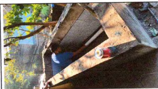
FOTO 10: Sustitución de pila de cemento de dos lavadero EN COCINA
