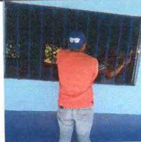
FOTO 6: Mantenimiento a balcones de metal
