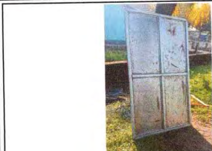
FOTO 13: Sustrucción de puerta 2X1 Metro EN AULA
